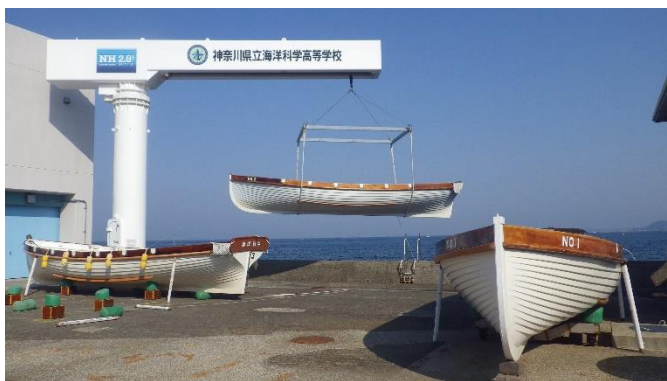
カッターとクレーン
